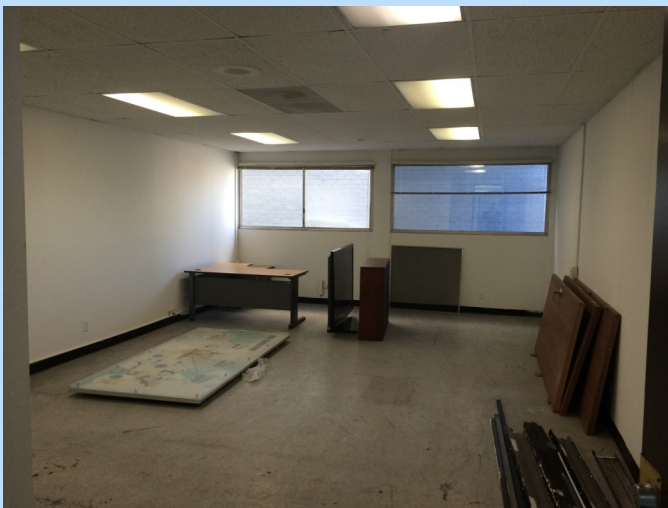
< 비디오 업무 사무실 사무공간 조성 (전) >
