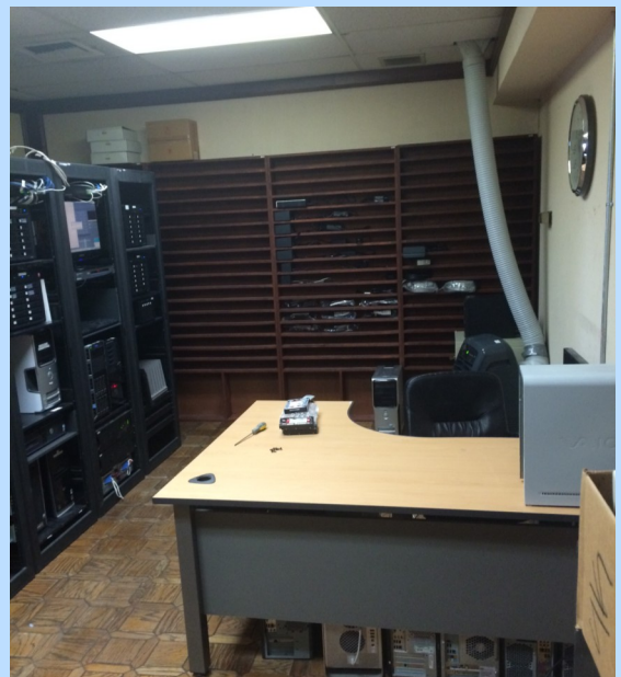
< 2층 서버룸 공사 (후) >
